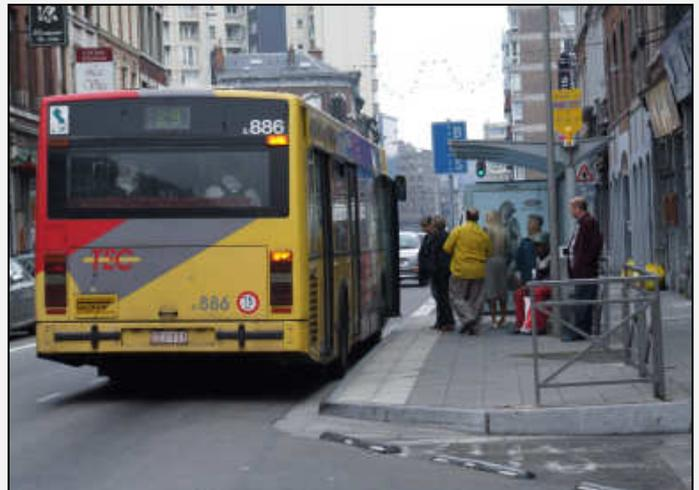
La contre-alvéole permet un bon accostage mais peut engendrer des encombrements (le bus bloquant une bande de circulation). © ACTP
