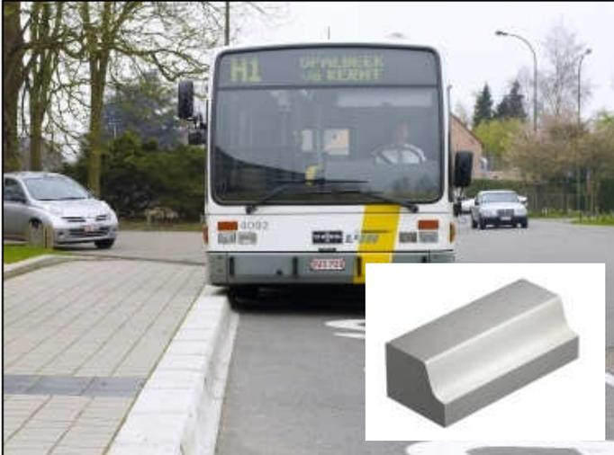
En guidant le bus lors de son accostage, les bordures profilées permettent de réduire les lacunes horizontales et verticales entre le quai et le plancher des véhicules (50mm). © URBAMAT
